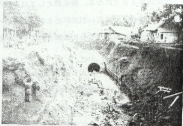
Djatiluhur 水路 トンネル工法 GAIIR 浄水場附近
