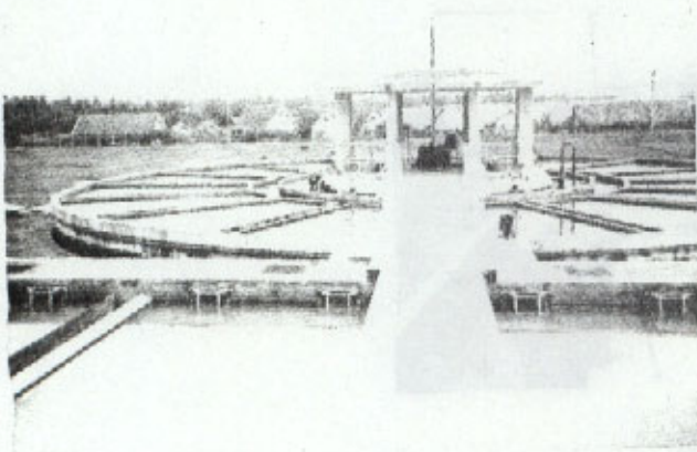
Pedjompongan 浄水場 沈でん池(アクセレータ)
