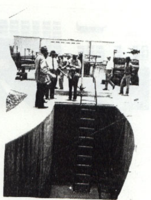
Pedjompongan 浄水場 取水口
